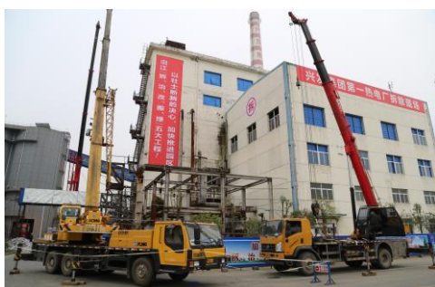
◀ 拆除第一热电厂
