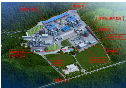
▲ 龙马磷业黄磷尾气综合利用项目
