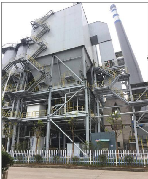
▲ “超低排放”改造项目
